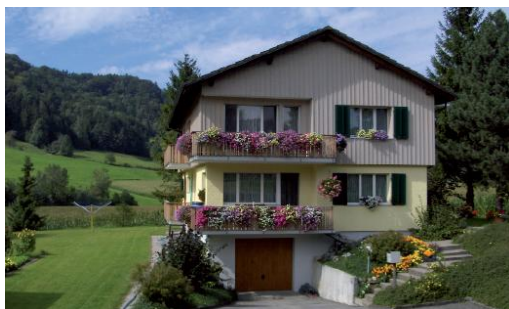
La maison des gérants, construite en 1975, retrouva elle aussi tout son éclat en 2010.
